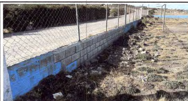
Foto 6: Pintura en muros exteriores e interiores
