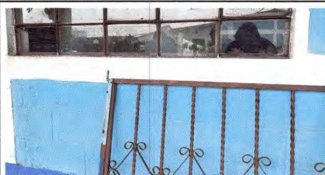
Foto 4: Sustitución de balcones de metal
