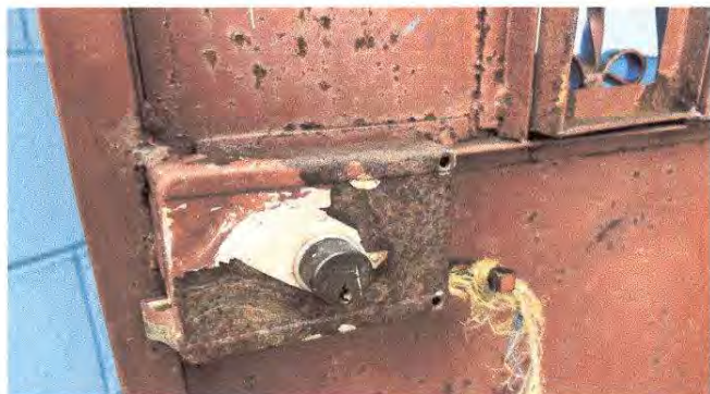
Foto 1: Sustitución de chapa
