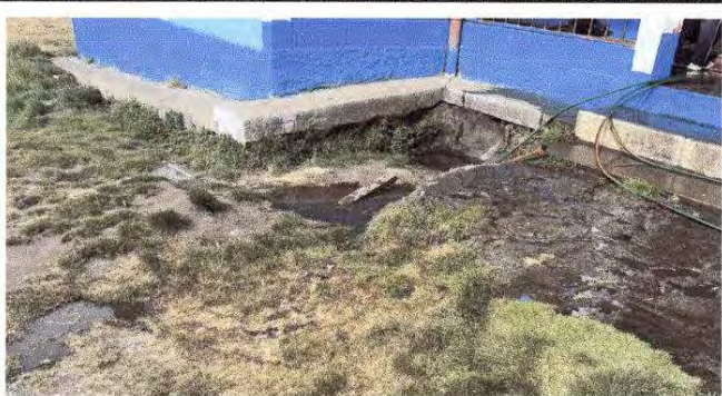
Foto 8: reparación de planchas de concreto de patio
