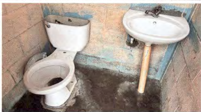
Foto 6: sustitución de inodoro, lavamanos y migitorio
