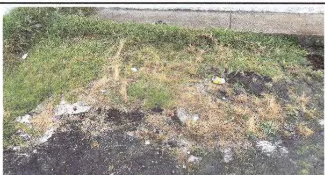
Foto 5: Reparación de piso de torta de concreto
