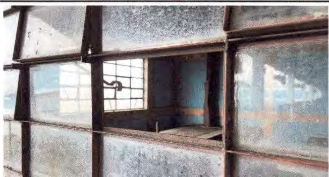
Foto 3: Sustitución de vidrios
