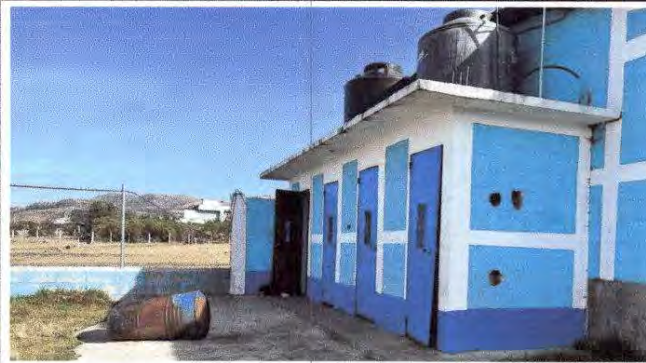
Foto 7: reparación de muro perimetral de block
