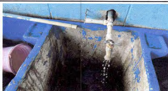
Foto 11: sustitución de pila de cemento de 2 lavaderos
