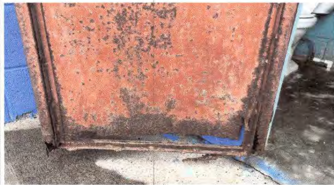
Foto 2: Sustitución de puertas en servicios sanitarios
