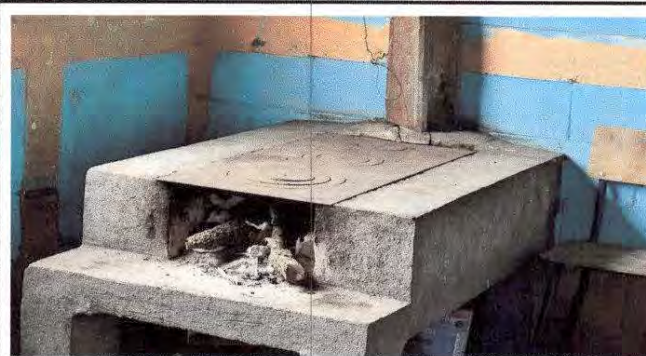
Foto 9: sustitución de planchas de metal de tres hornillas
